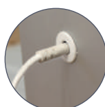
Zabezpieczone wejście na kabel
